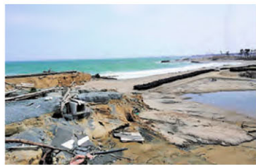
《道がつながっていたはずであるが、500~600m位の間の道路、堤防、地形が削られている》
