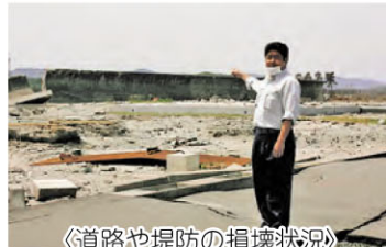
《道路や堤防の損壊状況》
