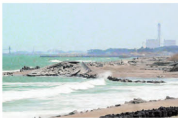
《道がつながっていたはずであるが、500~600m位の間の道路、堤防、地形が削られている》
